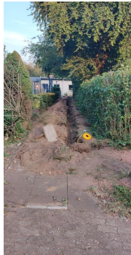
Die umfangreichen Erdarbeiten
