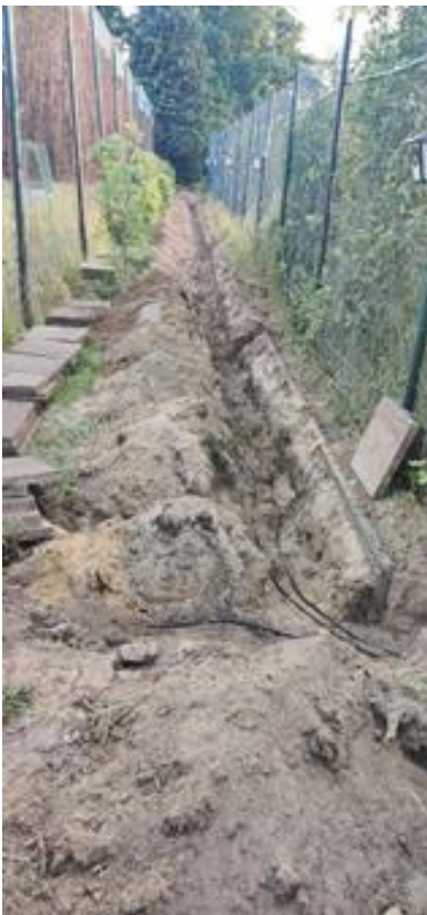
Die umfangreichen Erdarbeiten
