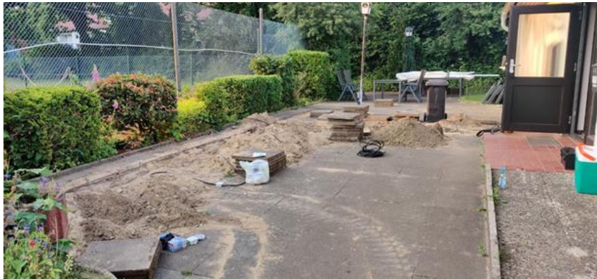
Die umfangreichen Erdarbeiten
